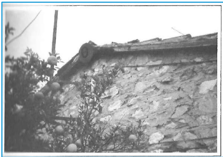
Τα Τετράγωνα αριθμήθηκαν με τα γράμματα της αλφαβήτου Α, Β, Γ, κ.λπ. Στη φωτογραφία σπίτι στο Τετράγωνο Θ (Δορυλαίου με Λεωφόρο Ειρήνης)
