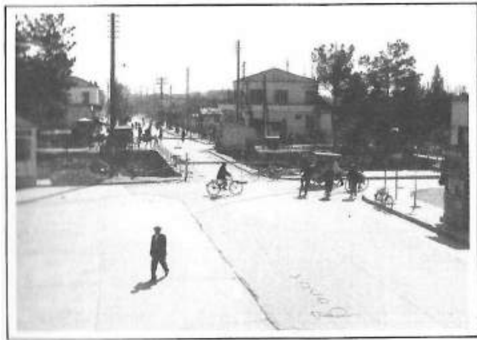
Η πρώτη κεντρική γέφυρα του Κραυσίδωνα, που κατασκευάστηκε το 1925. Εδώ σε φωτογραφία του 1963 λίγο πριν κατεδαφιστεί (Αρχείο Ιωάννη Μαλαμούση)
