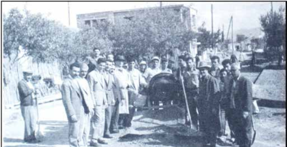
Έργα στους δρόμους (ταιμεντοστρώσεις) της Νέας Ιωνίας (με μπετονιέρα της εποχής εκείνης) από τον Δήμαρχο Απόστολο Βολίδη (1959-1964), που διακρίνεται δεξιά (με το ρεπούμπλικο). (Φωτογραφία: Βασίλη Παλαμηδά).
