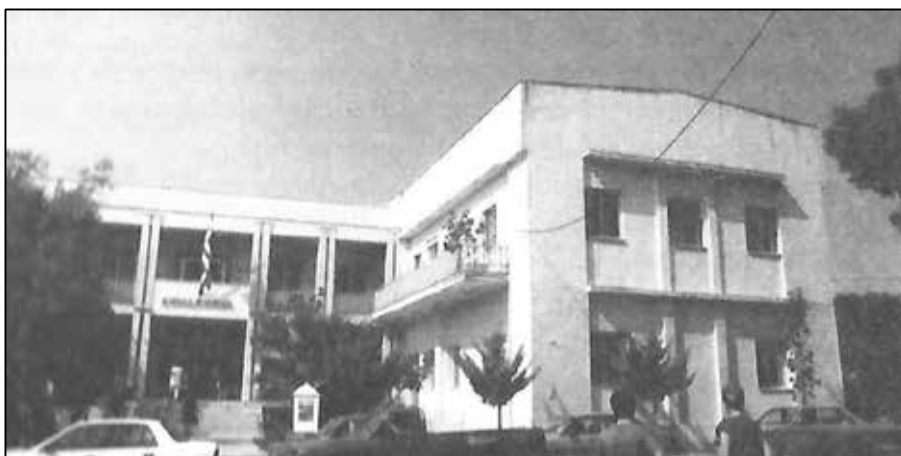
Το δημαρχείο της Νέας Ιωνίας ολοκληρώθηκε σε τρεις φάσεις: α) 1953: Το ισόγειο δεξιά επί δημάρχου Μιχ. Τίκογλου, β) 1972 επί δημάρχου Κων. Σουγιουλτζόγλου: Το ισόγειο αριστερά, γ) 1980 επί δημάρχου Ανδρέα Βαλαχή: Προστίθεται ολόκληρος ο δεύτερος όροφος.
